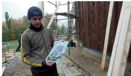
Рис. 4. Будівництво Церкви Покрови Пресвятої Богородиці. 2013. Фото Ю. Кардаша
