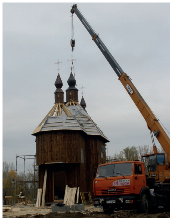
Рис. 5. Будівництво Церкви Покрови Пресвятої Богородиці. 2013. Фото Ю. Кардаша
